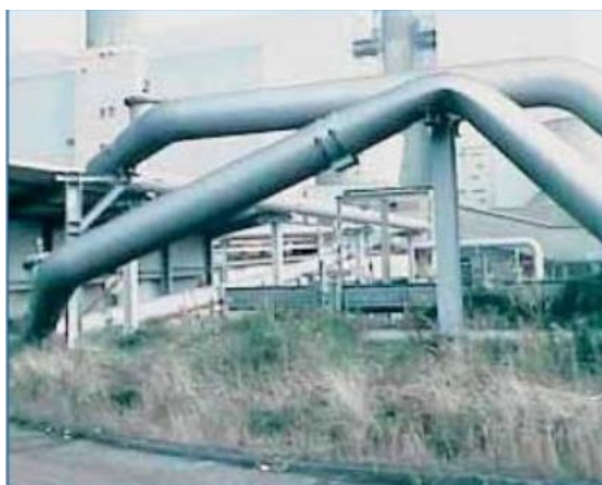
Сурет 1.1 – Толық ақша жинады қысымды құбыр DN600 (қабырғаларының қалыңдығы 12 мм)
